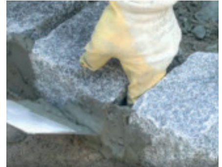
Pflasterfugen innen und außen mit Fugenmörtel verschließen
