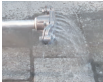
Fugensand leicht einregnen und abbinden lassen
