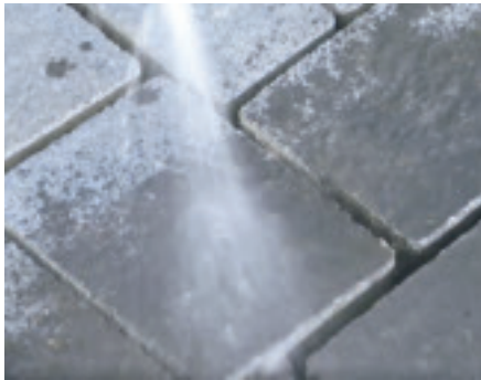
1. Natur-/Betonsteine oder Platten intensiv vornässen
