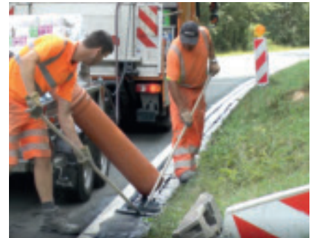
Nach Vornässen der Rinne Ausbringen des Fugenmörtels über Ablaufrinne
