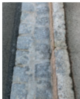
Rinne nach der Sanierung
