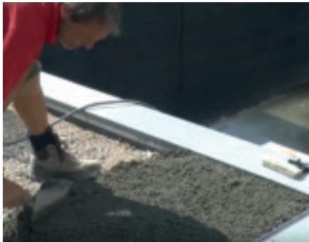
1. Portionsweises Ausbringen von JURALITH® BM 4 D Bettungsmörtel im Plattenformat und Nivellieren
