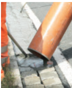
Verteilen und fugentiefes Einarbeiten des leicht fließenden Fugenmörtels
