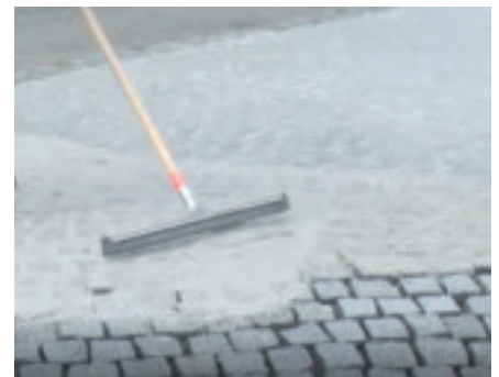
6. Fugenmörtel mit Gummischieber oder Besen satt einarbeiten
