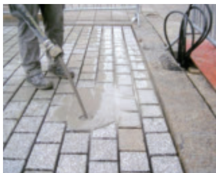
5. Verteilung mittels Schlauchleitung
