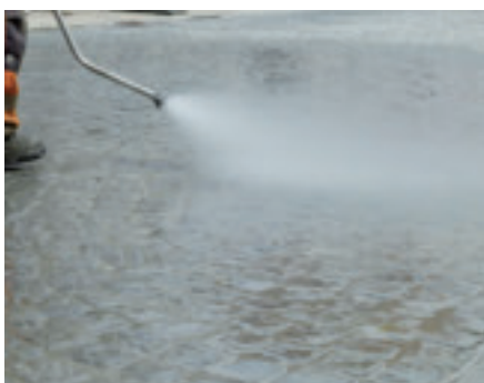
7. Reinigung mit Wasserstrahl-Handdüse
