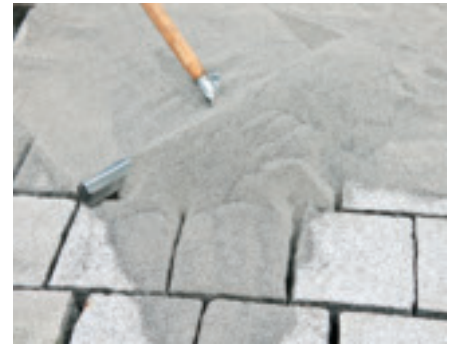
Ausbringung und Einarbeitung ggf. mit geeigneter Rüttelplatte, Pflasterbelag abrütteln und Fehlstellen nachkehren
