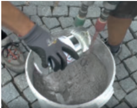
1. Komponente 1 (Bindemittel) der Komponente 2 (Fugensand) während dem Durchmischen hinzufügen
