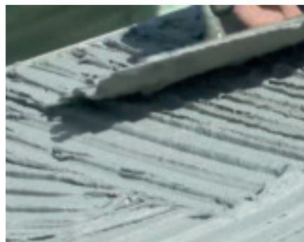
5. Flächiges Aufbringen des Klebers mit Zahnpachtel
