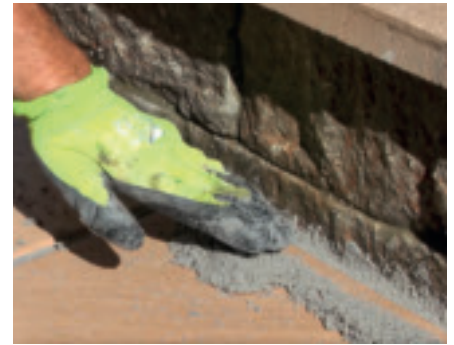
6. Wand- und Mauerabschlüsse sauber verfüllen
