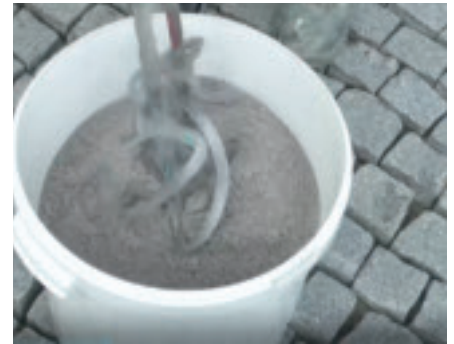
3. Verarbeitungsfertig homogen durchmischen
