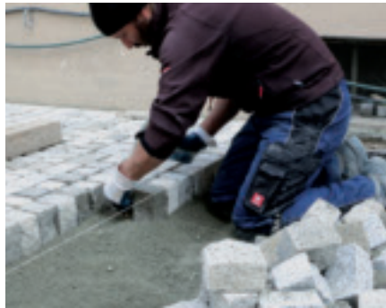
2. Hammerfestes Verdichten des Bettungsmörtels
