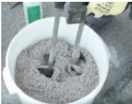
4. Komponente 1 und 2 gut durchmischen
