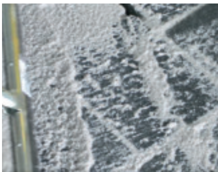
7. Fugenmörtel auf Pflasterfläche ausbringen, mit Gummischieber verteilen und in Fugen einarbeiten
