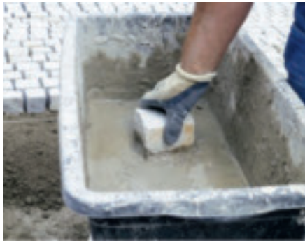
1. Tauchen oder Streichen der Kontaktschlämme
