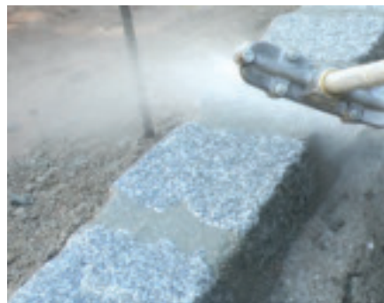
Endreinigung mit JURALITH® Breitstrahldüse oder Hochdruckreiniger
