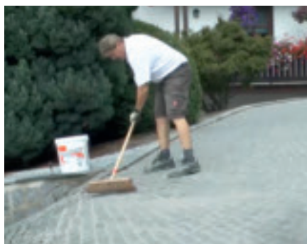
8. Mit Kokosbesen das Pflaster endreinigen - fertig
