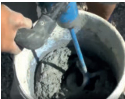
4. Nach kurzer Reifezeit den Kleber streichfertig durchmischen
