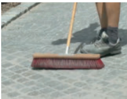
7. Anschließend Pflasterfläche mit Besen grob reinigen (kreuz und quer)
