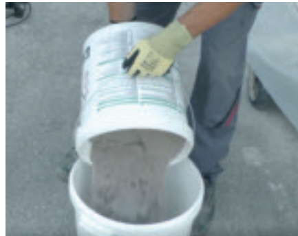
2. Komponente 1, Fugensand in Mischgefäß umfüllen
