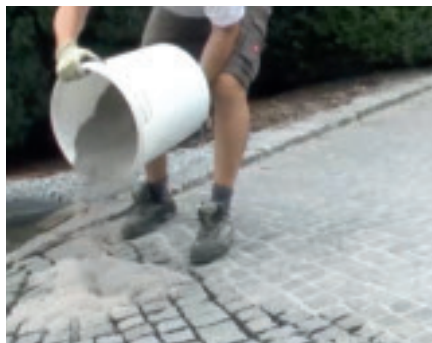
5. Fugenmörtel KFM 280 auf Pflasterfläche ausbringen
