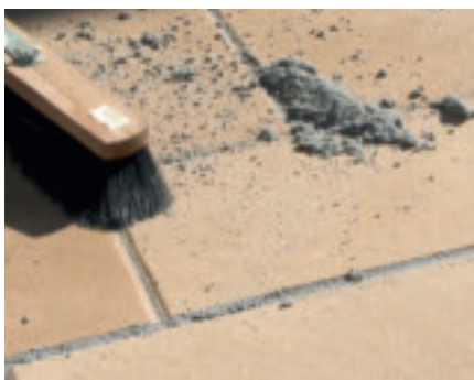
8. Belag nach kurzer Ansteifzeit mit weichem Besen gründlich reinigen - fertig
