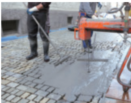
4. Anmischen und manuelles Verteilen
