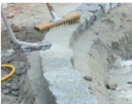
Nach kurzer Trockenzeit (Fingerprobe) Pflastersteine mit JURALITH® Breitstrahldüse und Besen/Schrubber vorreinigen
