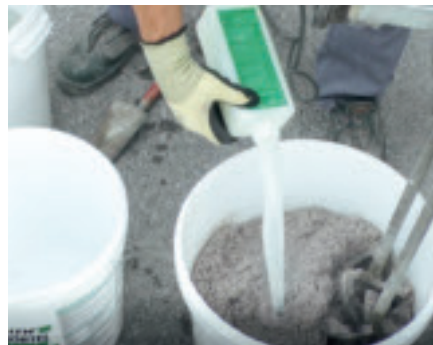
5. 2 Härterbehälter mit Wasser (2 Liter) hinzugeben
