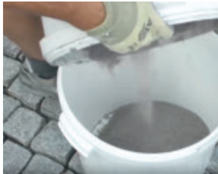
2. Eimerinhalt in zweites Mischgefäß umfüllen
