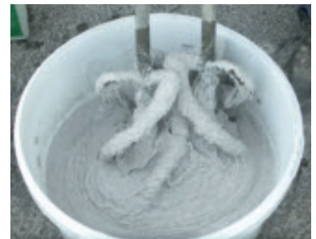
6. Verarbeitungsfertig homogen durchmischen
