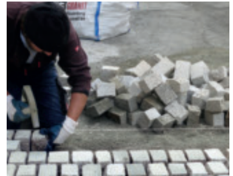
3. Höhengerechtes Versetzen mit gleichem Fugenmaß
