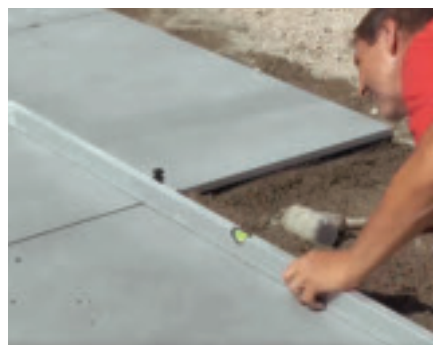
8. Ausnivellieren und Verfugen mit JURALITH® Fugemörtel oder Fugensand - fertig
