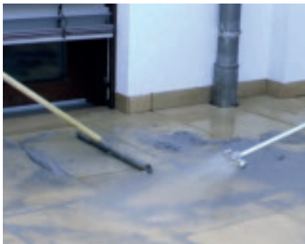
5. Fugenmörtel mit JURALITH® Wasserstrahl-Handdüse zügig in die Fugen einschwemmen und mit Gummischieber satt einarbeiten
