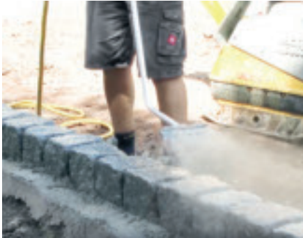
Pflasteraufbau mit Hochdruckreiniger oder mit JURALITH® Breitstrahldüse vornässen
