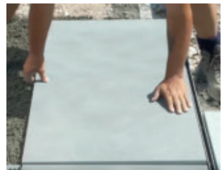
6. Passgerechtes Nass-in-Nass Setzen der Platte in das frische Mörtelbett und Ausnivellieren
