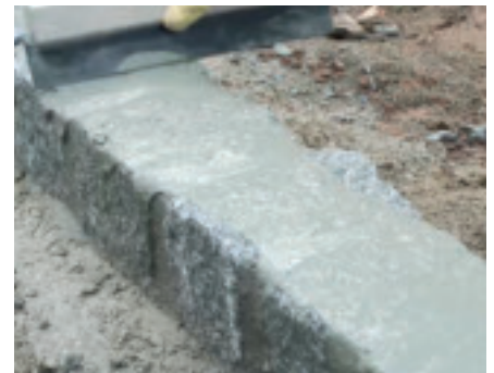
Fugen mit Gummischieber glätten
