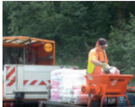
Maschinelles Anmischen der ZFM 750/2 ZRB Sackware
