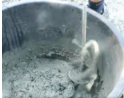
Pflasterfugenmörtel-Sackware unter Zugabe von Wasser standfest durchmischen
