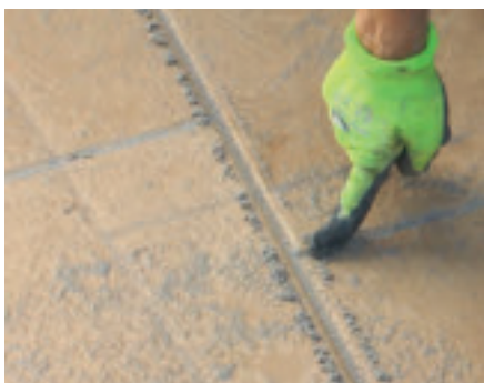
7. Bei Platten mit Fase Fugen bis auf die Tiefe der Fase vertiefen
