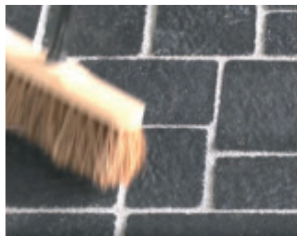
8. Nach kurzer Ansteifzeit Mörtelreste mit einem weichen Besen quer zur Fuge abkehren – fertig
