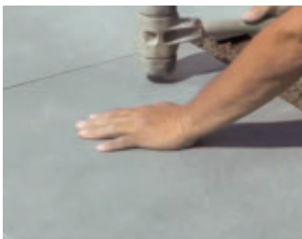
7. Höhengerechtes Setzen der Platte
