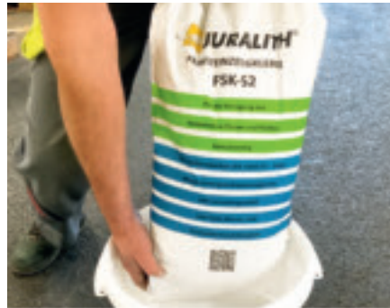
2. Feinsteinzeugkleber für die Verarbeitungszeit von ca. 20 Minuten vorbereiten
