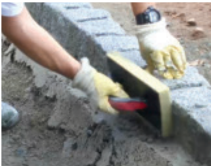
Fugen mit Reibebrett vorreinigen
