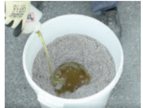
3. Komponente 2, Härter in kleine Vertiefung im Fugensand hinzufügen
