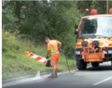
Tiefgründige Reinigung der Pflasterfugen mit Hochdruckreiniger
