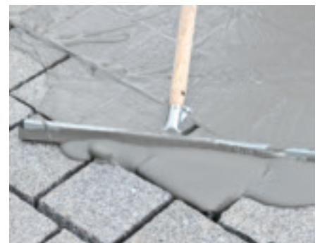
6. Hohes Fließverhalten des JURALITH® Pflasterfugenmörtels
