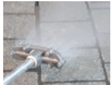
Nach dem Abbinden Pflasterfläche mit Wasser(Strahl) reinigen
