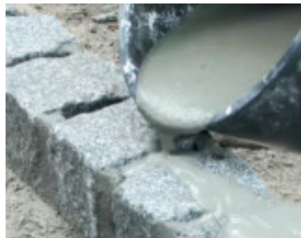
Pflasterfugenmörtel fließfähig anmischen und Fugen vollständig verfüllen
