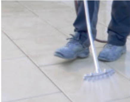
1. Fliesen mit JURALITH® Wasserstrahl-Handdüse intensiv vornässen
