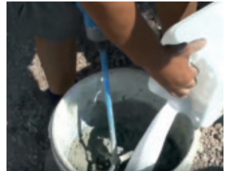
3. Anmischen des JURALITH® 2-Komponenten-Feinsteinzeugklebers mit zugehöriger Anmachflüssigkeit
