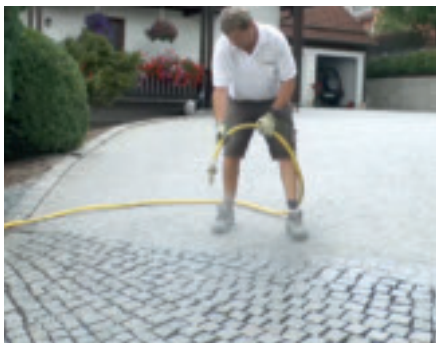
4. Pflasterflächen intensiv vornässen. Dabei Pfützenbildung vermeiden
