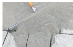
3. Ausbringung und Einarbeitung ggf. Pflasterbelag abrütteln, Fehlstellen nachkehren
