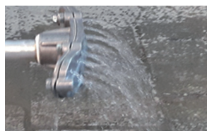
5. Fugensand leicht einregnen lassen und ansteifen lassen
