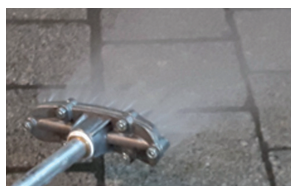
6. Nach dem Ansteifen Pflasterfläche mit Wasser(-strahl) reinigen
